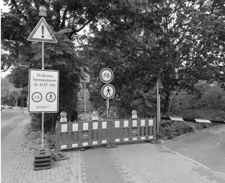
Nur der Aufgang ist von der Fußgängerbrücke noch geblieben
