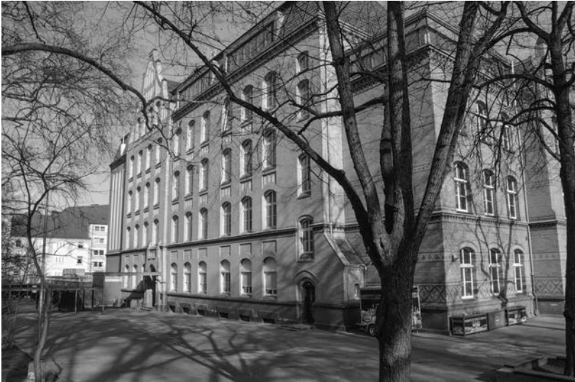
Nach dem Ende der Bauarbeiten gibt es wieder einen freien Blick auf das Gebäude der Grundschule. - Foto: Pike
