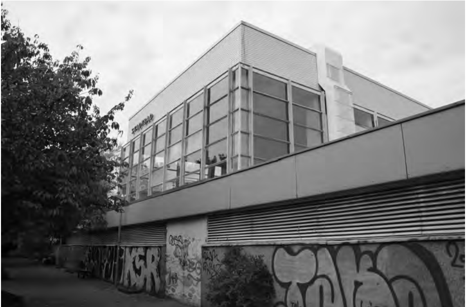
Das Unterrather Hallenbad ist sanierungsbedürftig und muss neu gebaut werden.
