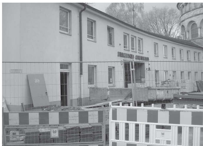
Gemeindehaus hinter dem Bauzaun
