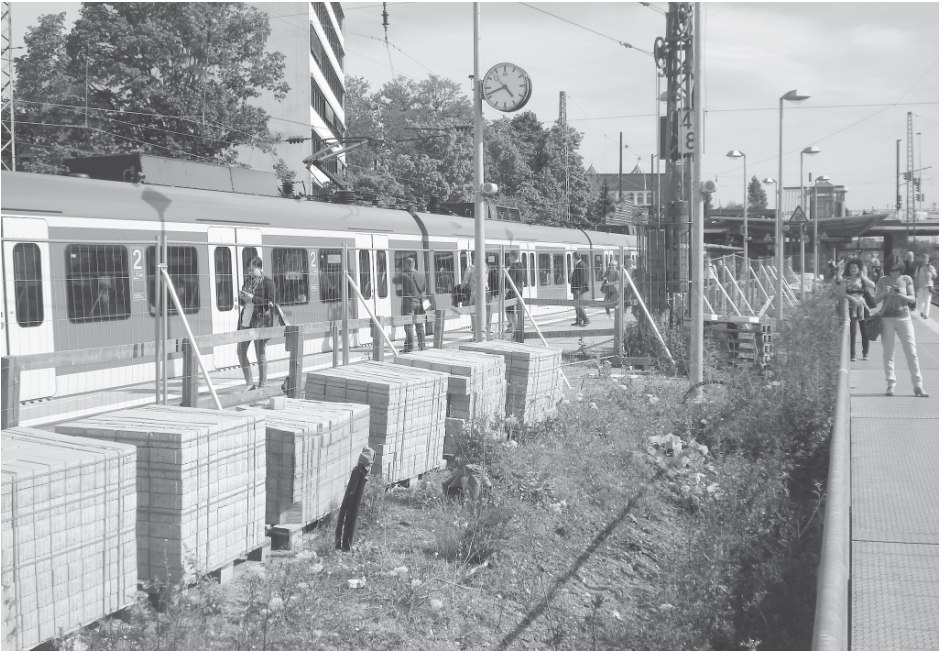
Baustelle auf dem Bahnsteig
